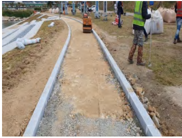
바닥 평탄화 작업
